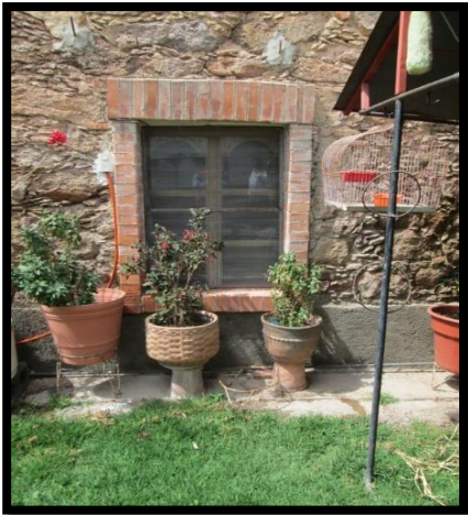
Fig. 6 Práctica de vanos en fachadas.
